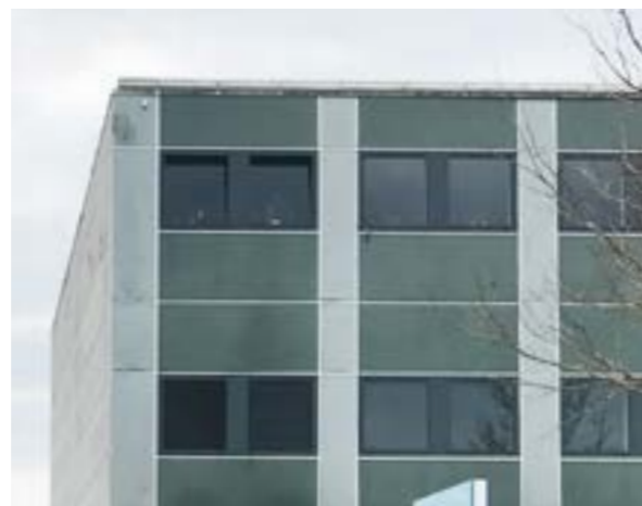
Eksisterende facade Ny Vestergårdsvej 21-23
