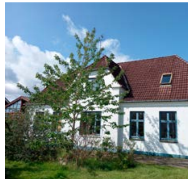
Hvidpudset facade med nyere skorsten
