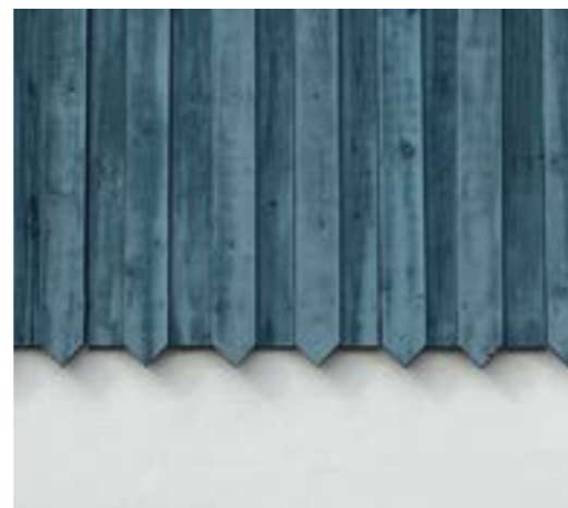
Eksisterende træfacade Ny Vestergårdsvej 17
