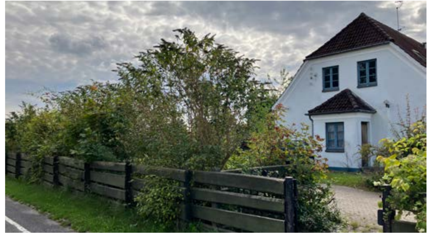
Bygning set fra Ny Vestergårdsvej
