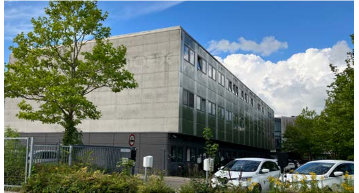
Bygning set fra Ny Vestergårdsvej
