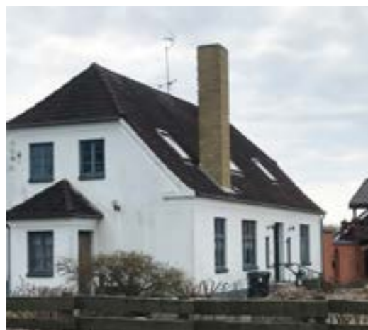
Eksisterende facade Ny Vestergårdsvej 17
